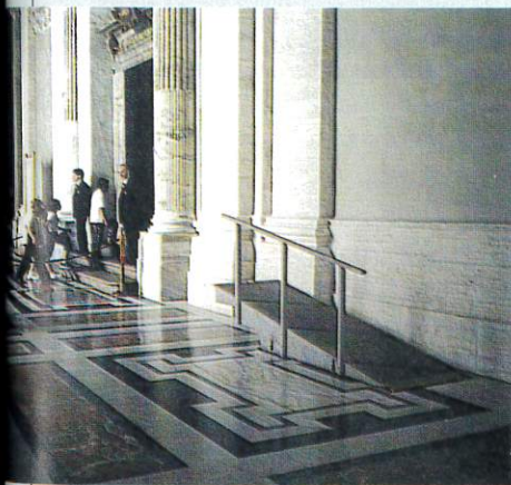
Porta Santa: la rampa c'è, ma viene evidentemente utilizzata solo quando necessario (a richiesta?): una buona occasione per "sottolineare" la diversità
