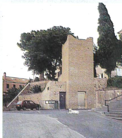
Uno dei due opportuni ascensori-torre
