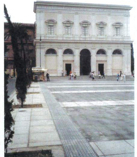
Tratti di percorso per non vedenti di fronte alla Scala Santa
